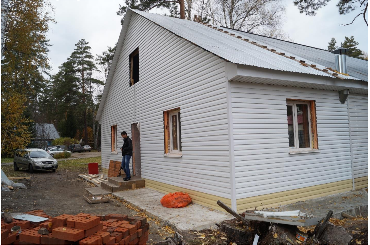
Рис. 25. Пристройка к лабораторному корпусу в ЮСБС
