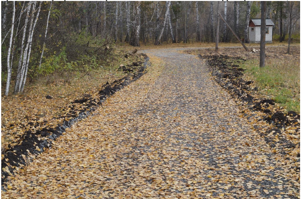
Рис. 24. Щебеночная дорога в соколятник
