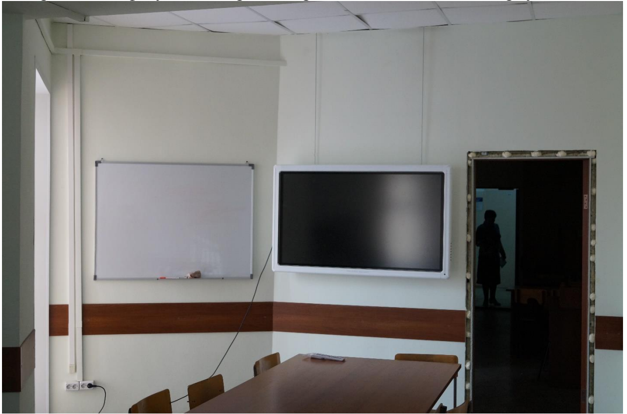
Рис. 26. Ремонт кабинета геоинформационных технологий
