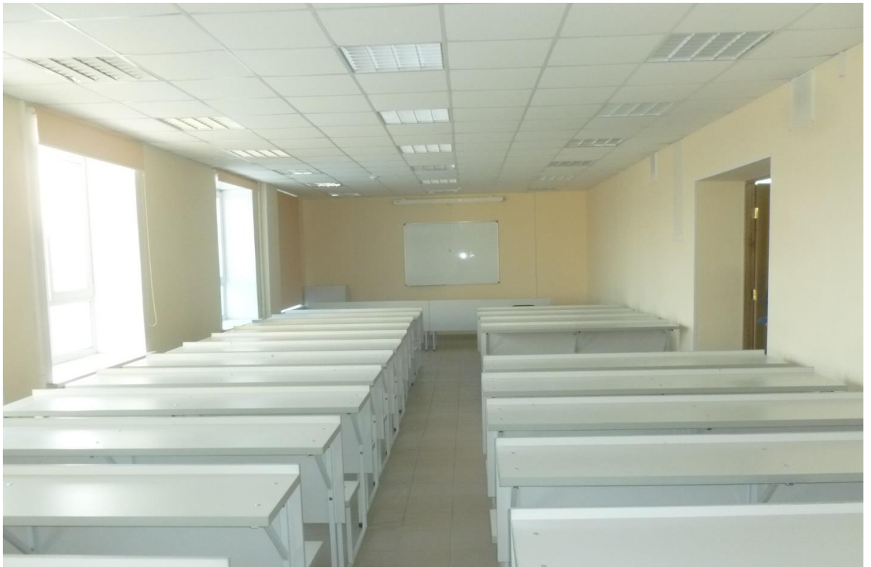
Рис. 28. Ремонт аудитории 403 «Д»
