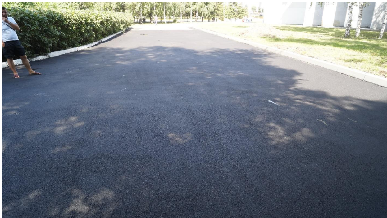
Рис. 22. Асфальтобетонное покрытие у корпуса «Д»
