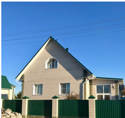
Рисунок 1. Жилой дом из ЛСТК на улице Отечественной
