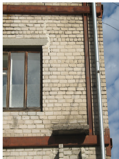
Рисунок 4 — Косая трещина, идущая по концу перемычки, длиной более 30 см
