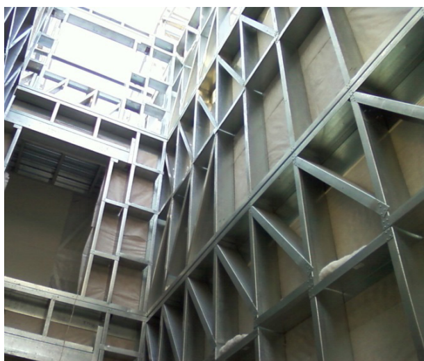
Рисунок 1 — Каркас здания на стадии строительства
