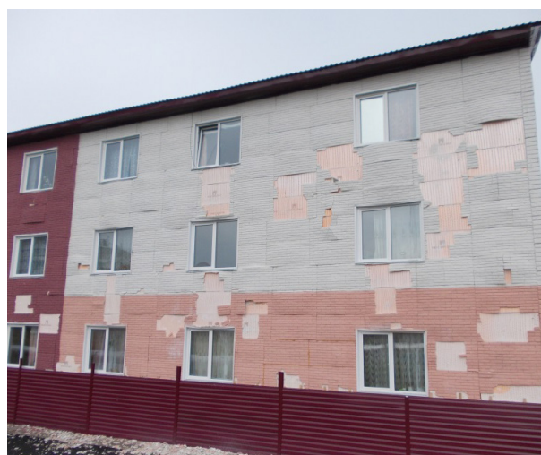
Рисунок 2 — Фасад здания после первого отопительного сезона
