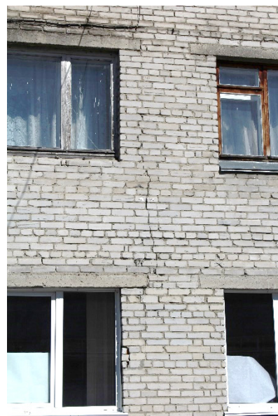
Рисунок 2 — Косая трещина, идущая по концу перемычки, длиной более 30 см
