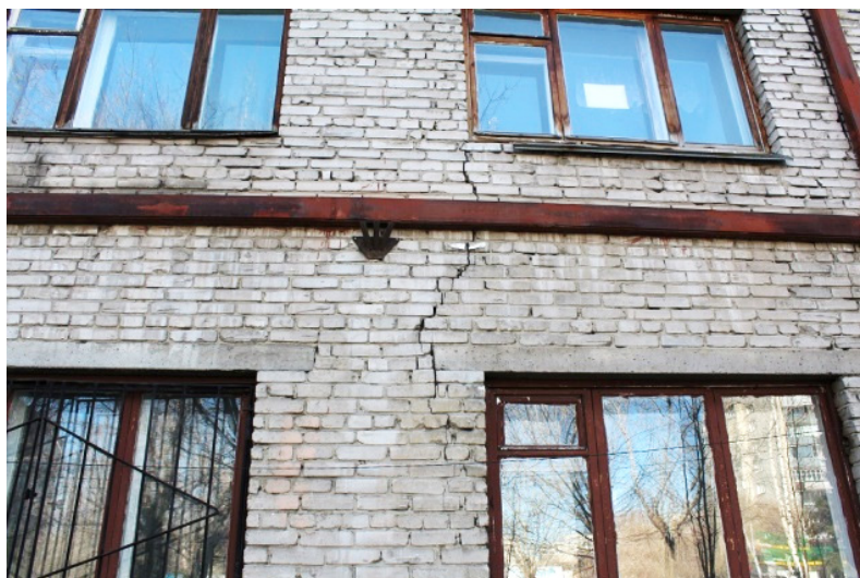
Рисунок 3 — Косая трещина, идущая по концу перемычки, длиной более 30 см
