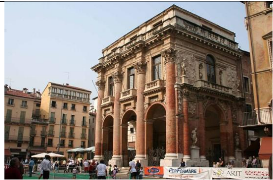
Ил. 35. Ордер перекрывает от 3 до пяти этажей, создавая впечатление монументальности и цельности фасада. Лоджия дель Капитаньо, Андреа Палладио
