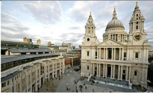
Ил. 46. Собор Св. Павла (St. Pauls Cathedral) на площади Ковент-Гарден (Covent Garden), архитектор Кристофер Рен (Christopher Wren)
